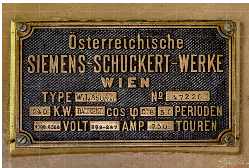
Фиг. 5.3. Табелка на един от действащите генератори.
